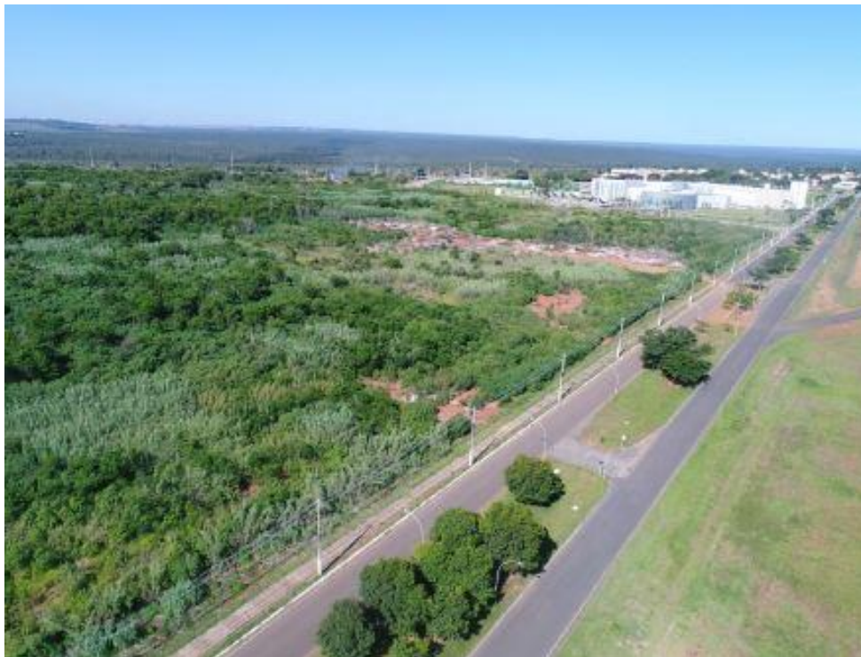
Vista geral do imóvel
